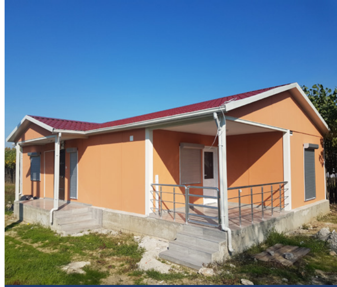
Prefabrik Tek Katlı Konut Sakarya
